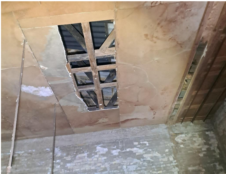
Figur 36. Kig til loft uden isolering. Nordlig del af 1. sal bygning 3. matrikel 2bk. ©DMR A/S.
