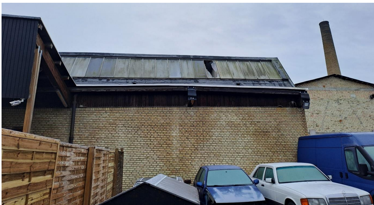
Figur 16. Knust rude bygning 2. Figur 14. ©DMR A/S.
